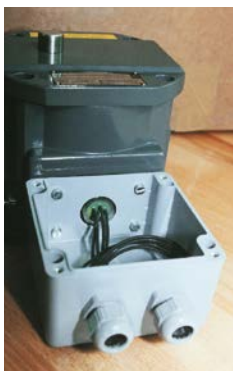
Проходная втулка в клеммной коробке Ex e
